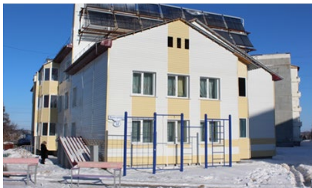
Эксплуатируется Амурская область, г. Шимановск, ул. Новостроящая, д.52 Ввод в эксплуатацию – 25.12.2012 г.
