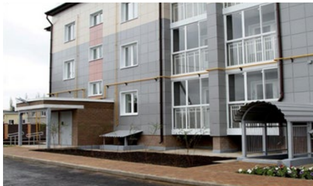
Эксплуатируется Липецкая область, г. Грязи, ул. Осоавиахима, д.16 Ввод в эксплуатацию – 31.12.2013 г.
